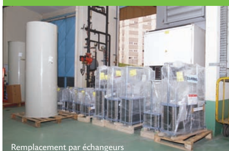
Remplacement par échangeurs
